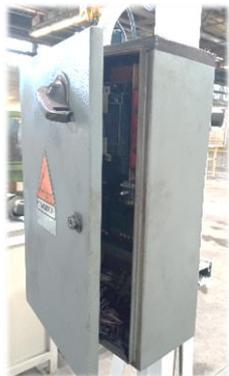
Открытая дверка электрического шкафа – риск получения электротравмы
