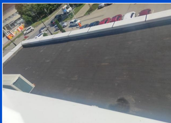
Частичная замена кровли здания Дома профсоюзов (лит. А2)
