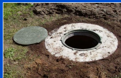
Отремонтированные оголовки и обновленные крышки колодцев
