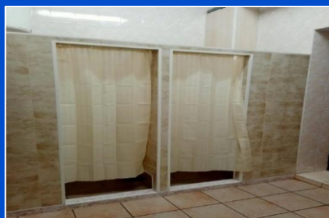
Замена перегородок между душевыми кабинами в спортивно-оздоровительном корпусе санатория
