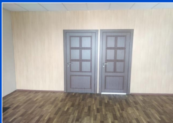
Замена дверей на 7 этаже Дома профсоюзов
